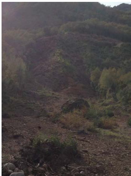
Foto 1: Zona de Tubería de Presión. Talado y limpiado.
