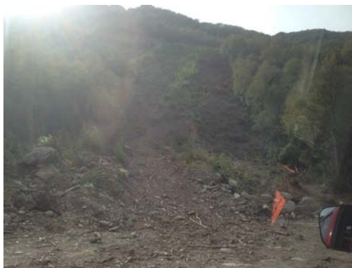
Foto 2: Zona de Rápido de Descarga. Talado y limpiado.
