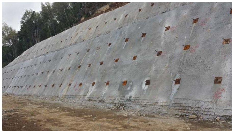
Foto 7: Taludes fortificados. Intersección de OC-102 y OC-103
